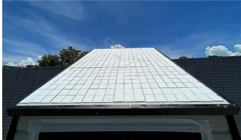
*Aplicación en la envolvente de un edificio, con la cerámica blanca de refrigeración aplicada en el tejado.
